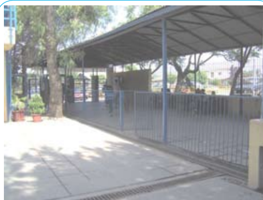
Foto 9 ANTES: Entrada a la escuela sin supervisión.
