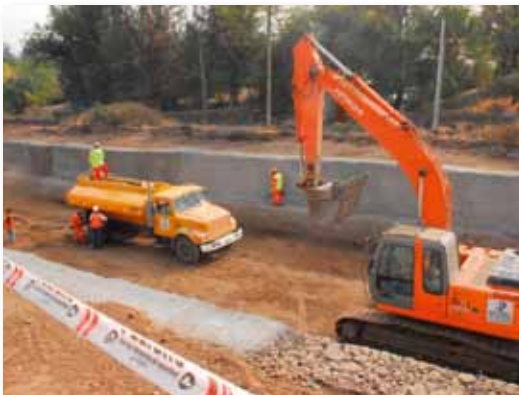
Movimiento de tierra.
