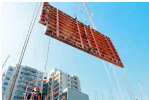
Izaje de materiales con torre grúa.
