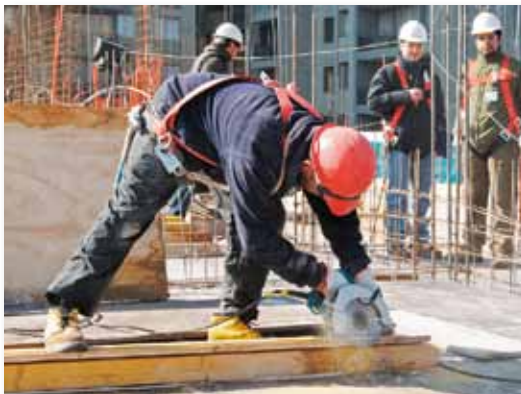
Uso de herramientas eléctricas en construcción.
